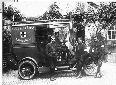
Voiture radiologique Massiot. Voiture équipée pour pratiquer la radiologie, service de santé militaire de l'armée française, avec quatre soldats. Source: gallica.bnf.fr
